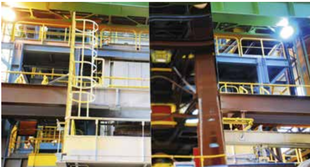
Een ArcelorMittal Usibor® Alusi bekledingslijn
